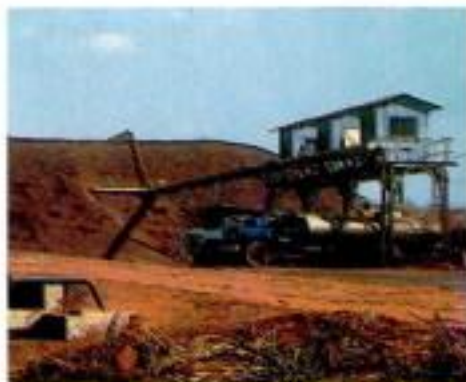
Figura 4. Abastecimento dos caminhões-tanque.
