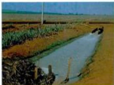
Figura 2. Canal de distribuição da mistura de vinhaça e águas residuais.
