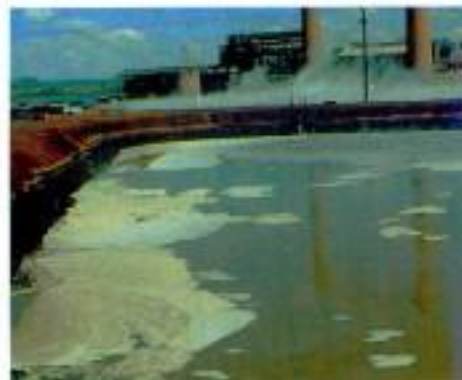
Figura 3. Tanque de armazenamento da vinhaça.
